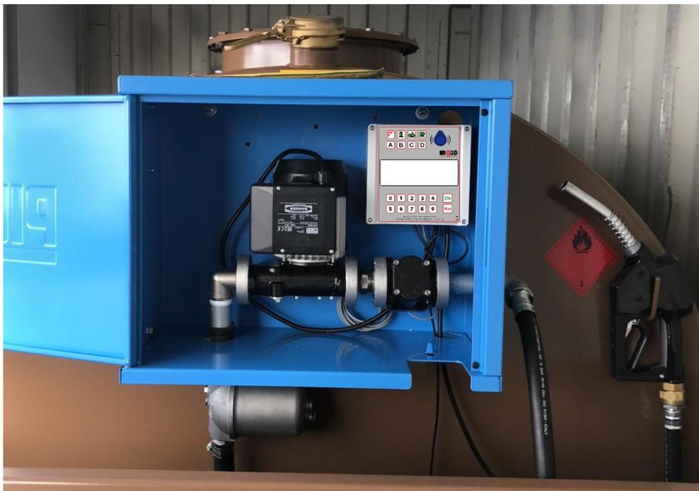
La funzione principale del Sistema Mago è consentire l'erogazione di carburante in modo controllato e pre-autorizzato. La chiave di accesso al rifornimento è un tag RFID ad avvicinamento.
